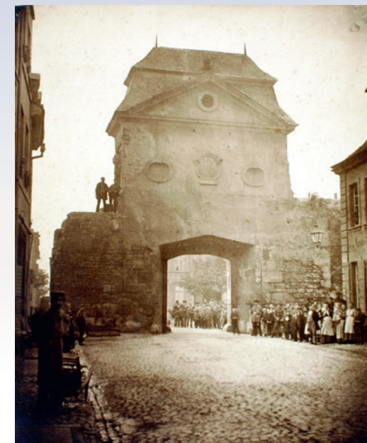
Das Neutor während des Abrisses, Stadarchiv Trier
